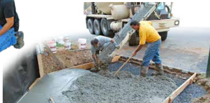
6 Se vacía concreto en el área a ser estampada.
