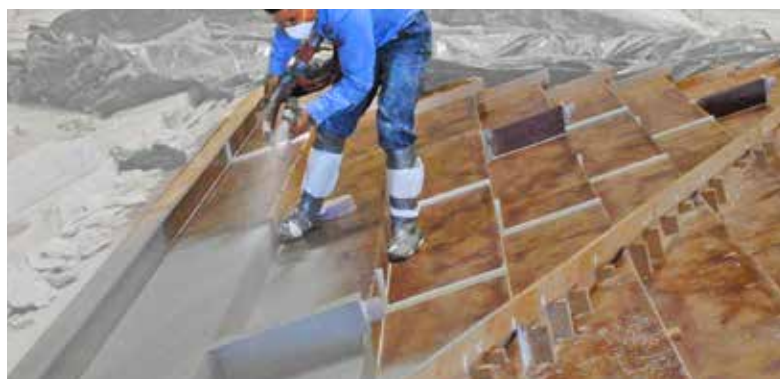
1 Se rocían dos capas de GRC con Forton® VF-774 sobre la superficie del molde.
