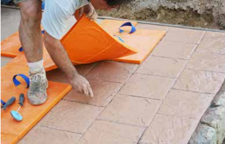
9 Al remover las estampas, se puede observar la textura impresa de baldosa.
