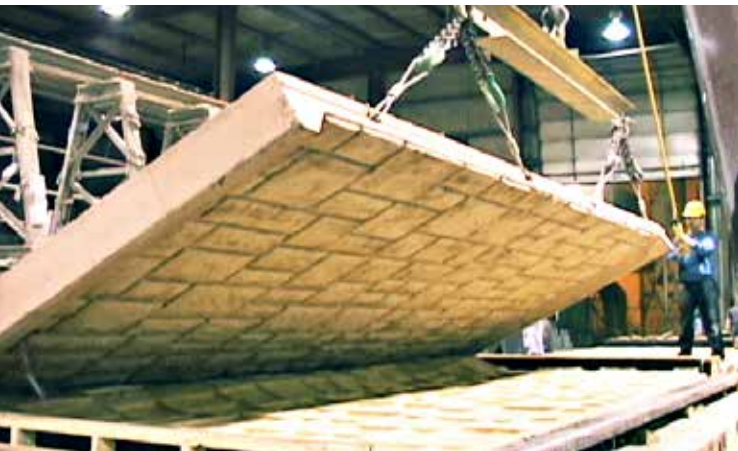
7 Utilizando una grúa, se levanta el panel de concreto de más de 4 toneladas.
