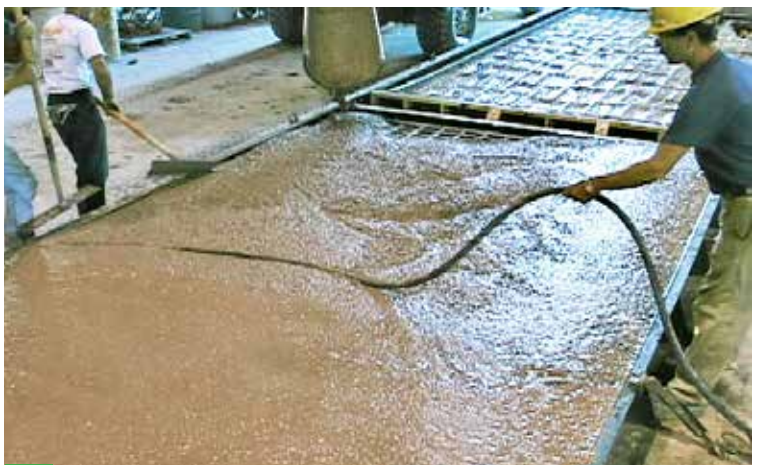
6 Se utiliza un vibrador para eliminar el aire atrapado.
