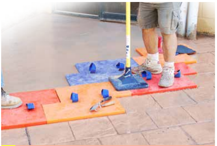
8 Las estampas son apisonadas manualmente para imprimir el patrón en el concreto.
