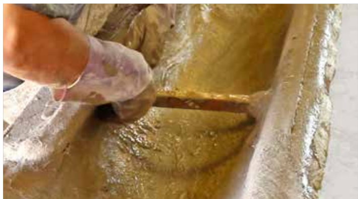
4 Listones de madera son incrustados en la parte trasera para la instalación.
