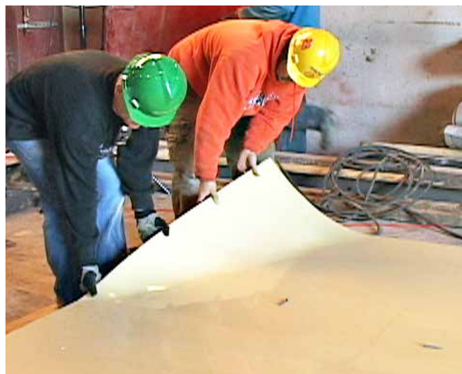
2 Se permite que el caucho endurezca y luego se desmolda.
