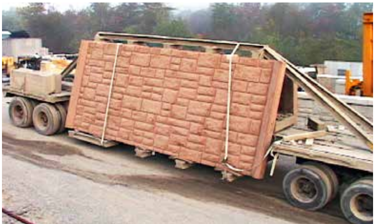
8 Los paneles terminados son entregados en el lugar de instalación.
