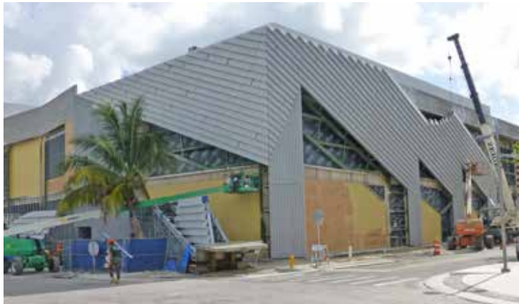
10 La instalación de los paneles de GRC es completada en solo unos días.
