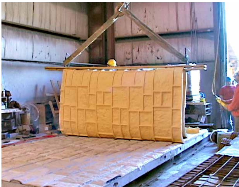
3 Se utiliza una grúa para levantar el tapete de más de 450 kilos.
