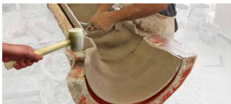
5 Los elementos de Forton® MG pueden ser desmoldados a los 60-90 minutos.
