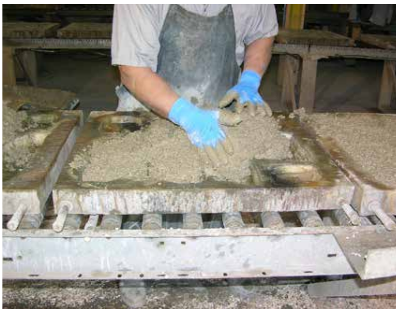
3 El concreto es vaciado en el molde.
