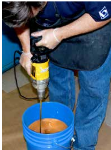
3 El PMG®-780 es pigmentado y mezclado mecánicamente.
