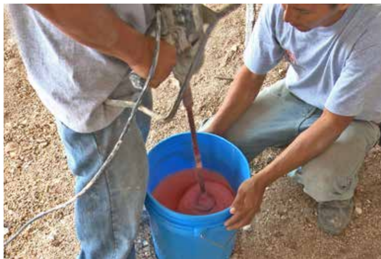
2 Rebound® 25 es mezclado 1A : 1B por volumen. Se utiliza una mezcladora para combinar ambas partes completamente.
