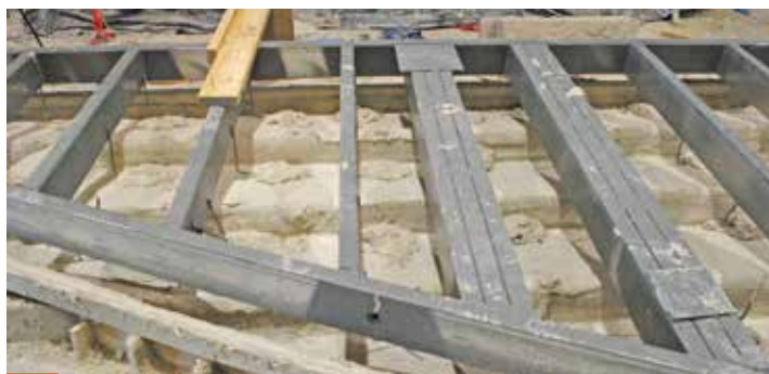
6 Se adhieren las anclas de acero del marco al panel de GRC utilizando mezcla adicional.
