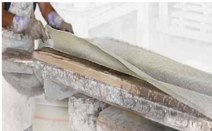
2 Una vez esta capa está parcialmente endurecida, se aplica el vidrio tipo 'E'.
