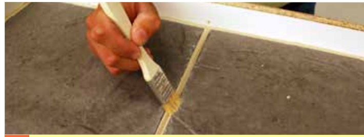
2 Se utiliza una brocha para crear una lechada con textura.
