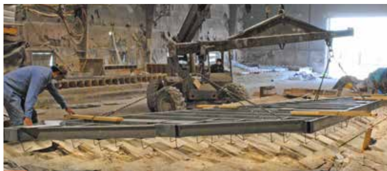
5 Un marco de acero estructural es colocado cuidadosamente encima del concreto.
