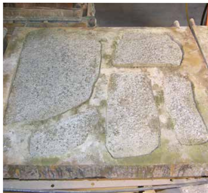
4 Se permite que el concreto fragüe por completo.
