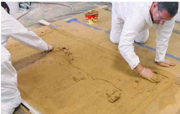
7 Se mezclan y aplican las capas de refuerzo, las cuales contienen fibra de vidrio AR.
