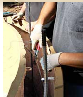
7 Se posicionan los paneles y se amarran con alambre a las varillas de refuerzo.
