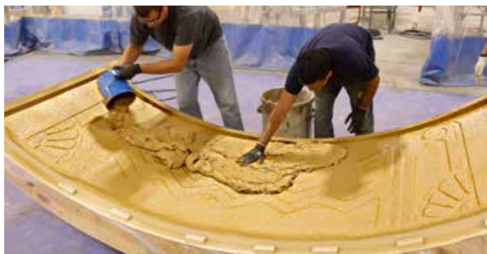
6 Se aplican las capas de refuerzo que incluyen fibra de vidrio AR.
