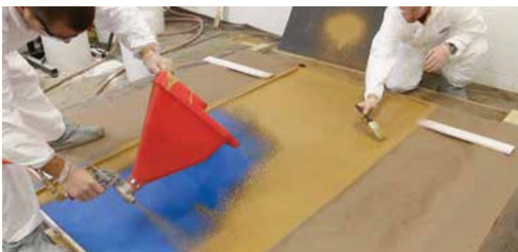
6 Se utiliza una pistola de tolva para aplicar la capa superficial.
