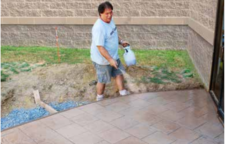
10 El concreto es teñido y sellado.
