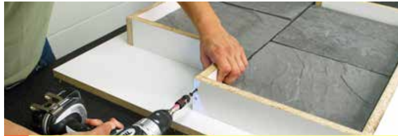
1 Se construye una caja con la forma de los adoquines.
