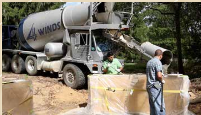
8 Se vacía concreto en el encofrado hasta llenarlo completamente.
