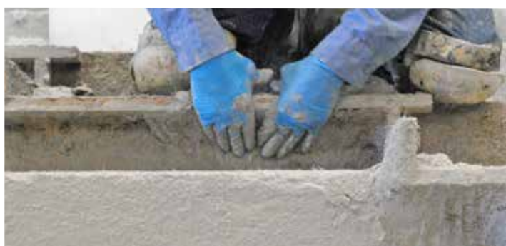
4 Se aplica mezcla adicional a mano en todas las esquinas y bordes.
