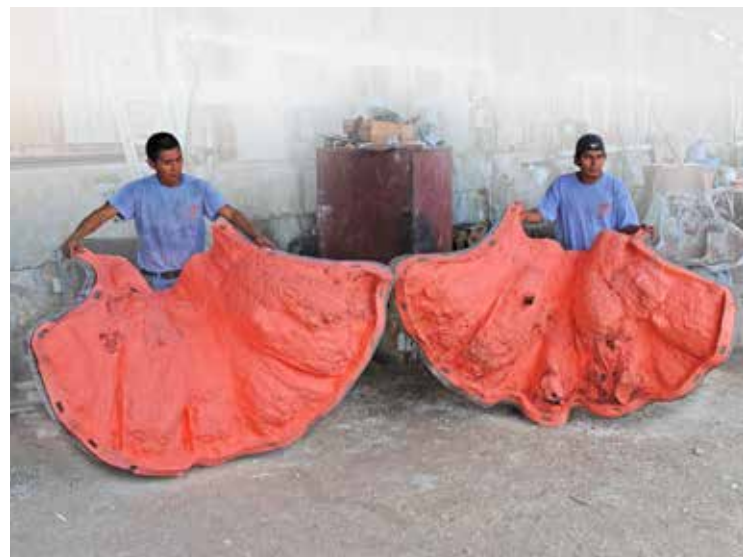
4 Se fabrica un contramolde. El caucho es removido del original y está listo para GRC.
