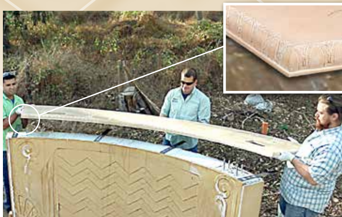
9 Se fabrican encimeras personalizadas y se instalan sobre la base.
