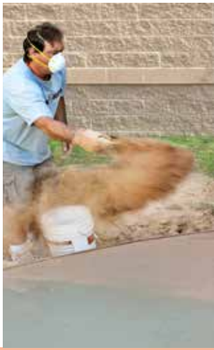
7 Se rasa el concreto y se añade endurecedor de color antes de estampar.
