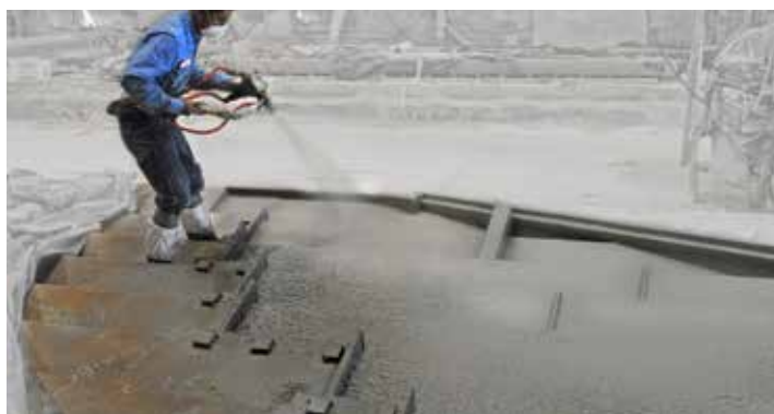
2 Se aplican capas adicionales reforzadas con fibra de vidrio AR.
