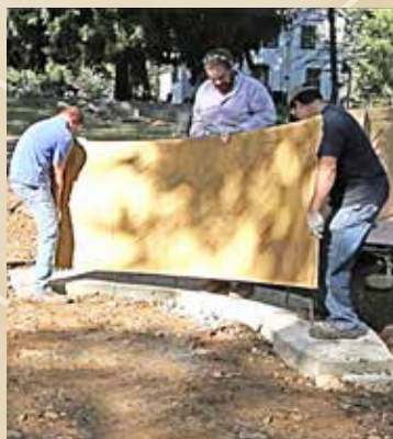
7 Se posicionan los paneles y se amarran con alambre a las varillas de refuerzo.
