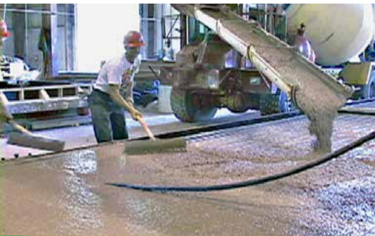
5 Se vacía concreto en el molde. El caucho VytaFlex® ofrece una excelente resistencia al peso compresivo sin distorsionarse.
