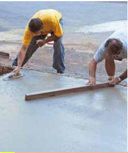
7 Se rasa el concreto y se añade endurecedor de color antes de estampar.
